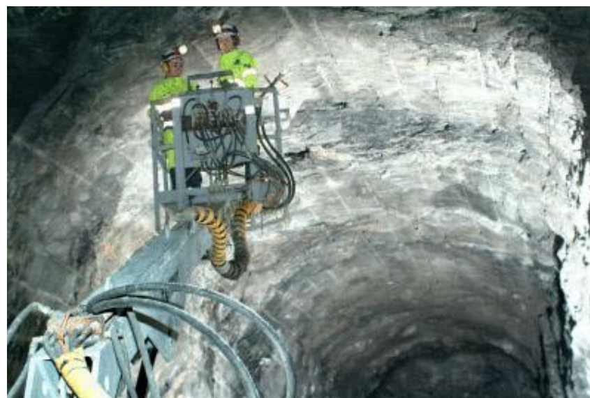
ONKALOn kalliopinnan geologista kartoitusta. (kuva: http://www.posiva.fi/onkalogallery.html )
