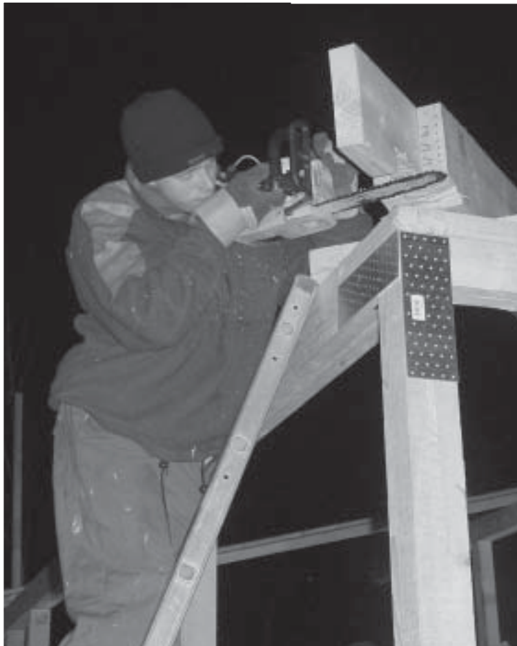
Raaka rakentaminenkin voi olla tarkkaa
